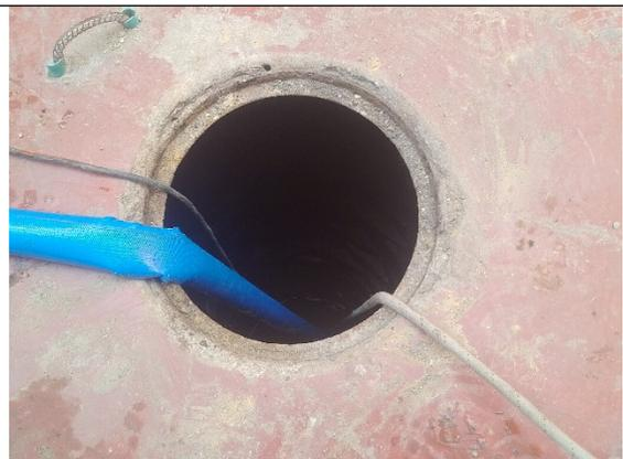
*Foto No.2 Extracción del agua por bombeo*
